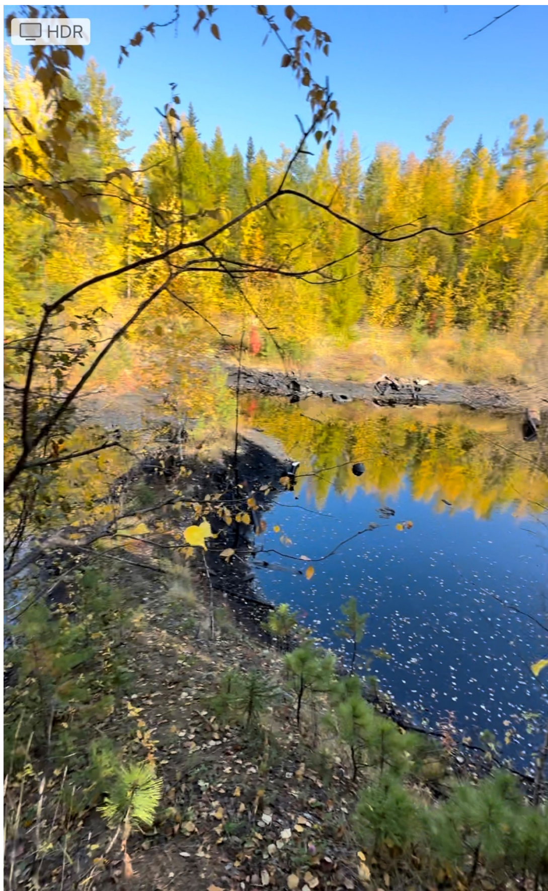
Рис. 15. Фото 8 – общий вид территории объекта строительства «Рекультивация нарушенных земель на 13 км автодороги Ленск-Мирный в Ленском районе Республики Саха (Якутия)». Вид на северо-восток.
