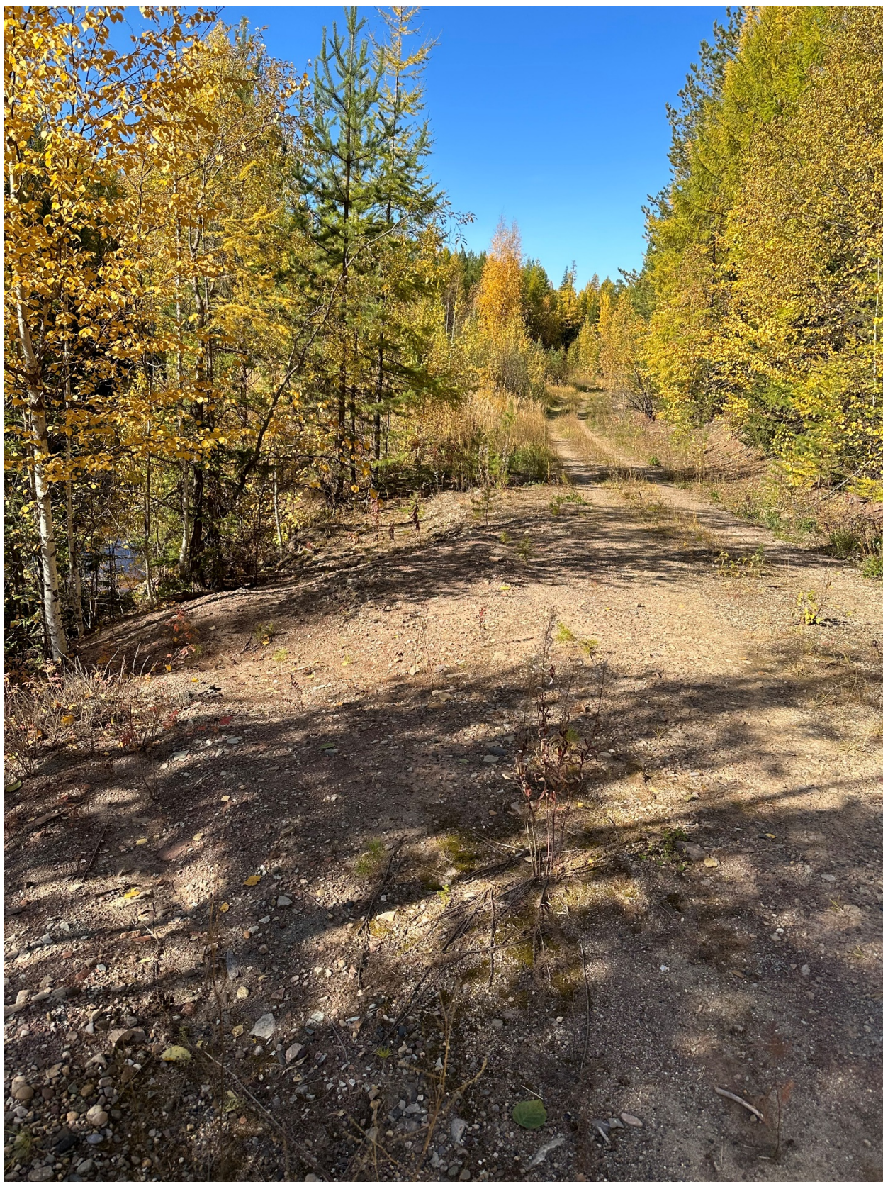
Рис .9. Фото 2 – общий вид территории объекта строительства «Рекультивация нарушенных земель на 13 км автодороги Ленск-Мирный в Ленском районе Республики Саха (Якутия)». Вид на запад-северо-запад.
