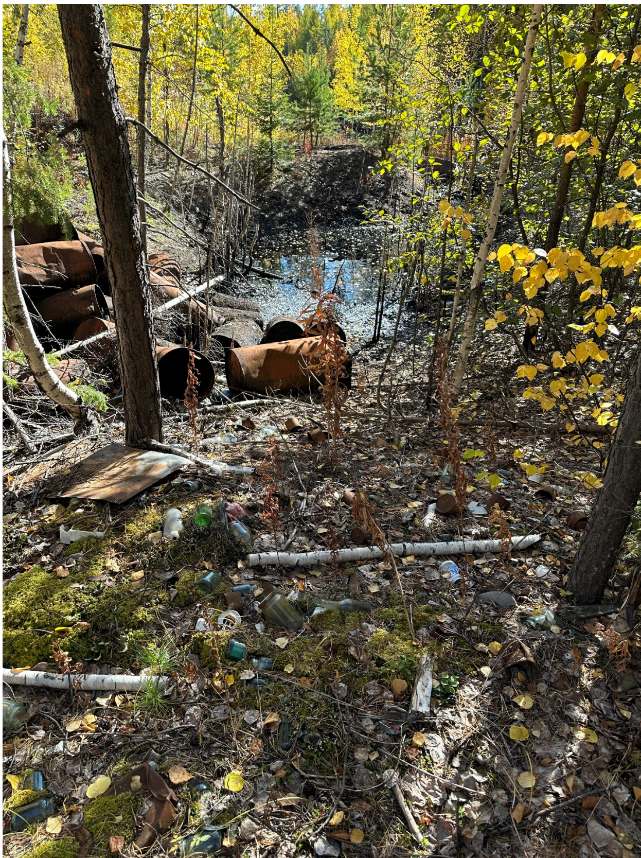
Рис. 11. Фото 4 – общий вид территории объекта строительства «Рекультивация нарушенных земель на 13 км автодороги Ленск-Мирный в Ленском районе Республики Саха (Якутия)». Вид на юг.
