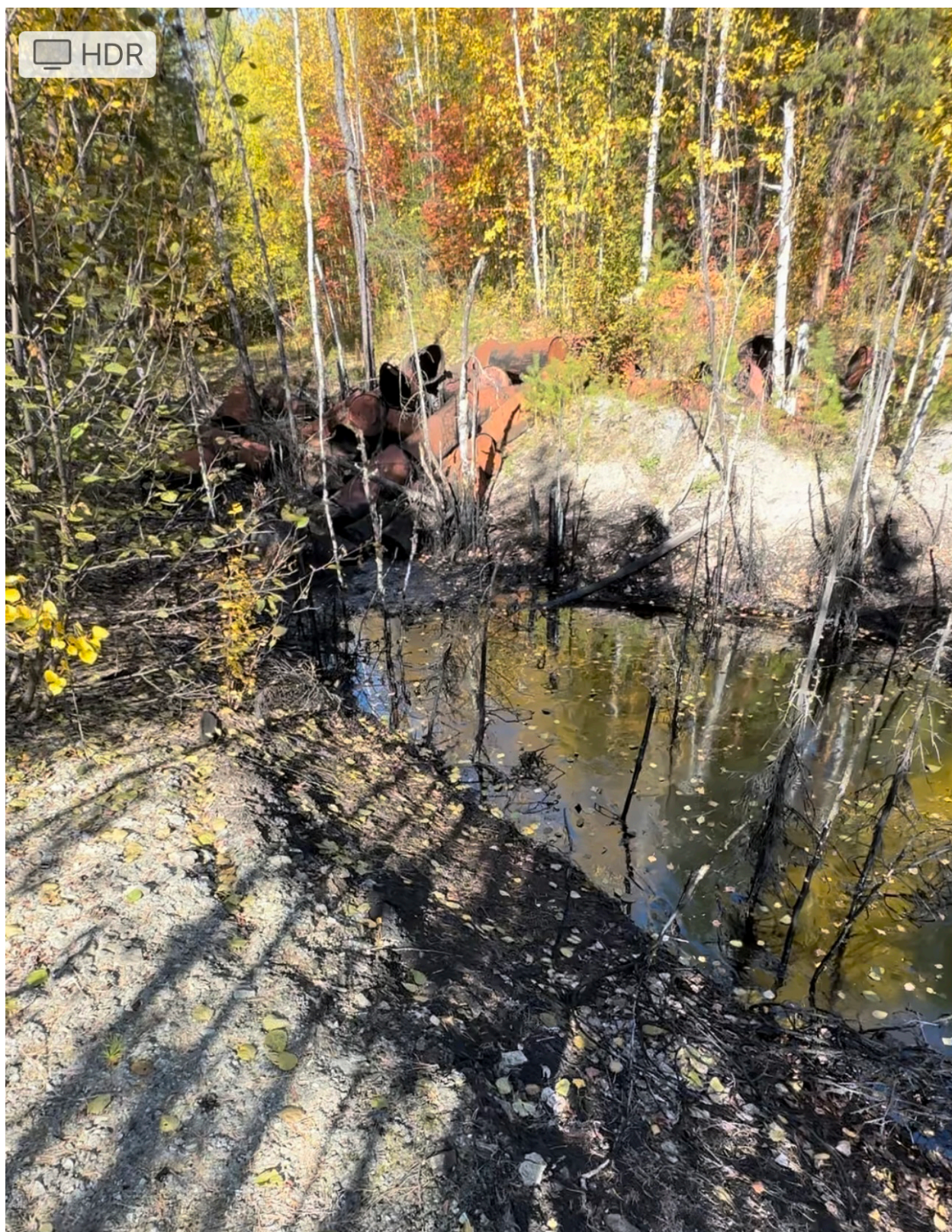
Рис. 14. Фото 7 – общий вид территории объекта строительства «Рекультивация нарушенных земель на 13 км автодороги Ленск-Мирный в Ленском районе Республики Саха (Якутия)». Вид на север.
